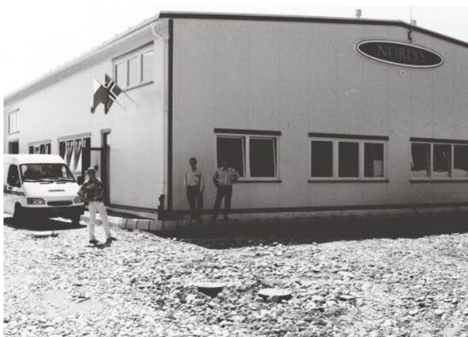
Åpning av produksjonshall (1998)
