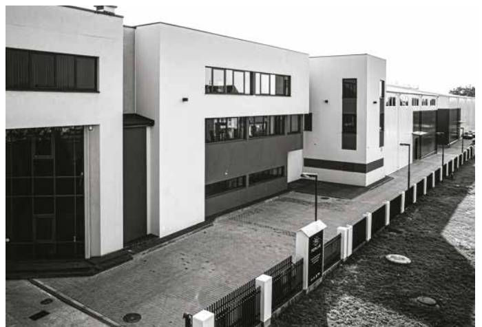
Ny monteringshall og lagerlokale (2015)
