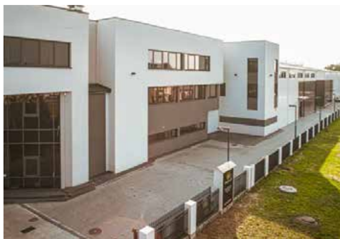
Nowy magazyn i montaż (2015)
