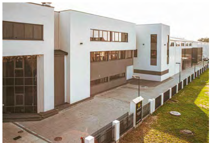
Nytt lager och monteringshall (2015)
