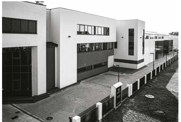
Ny monteringshall og lagerlokale (2015)
