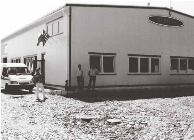
Åpning av produksjonshall (1998)
